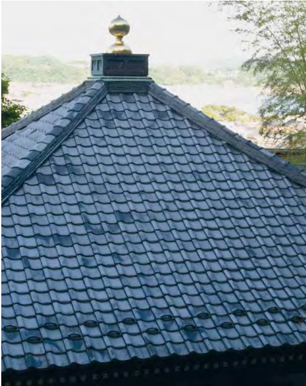
22.1. Cubierta a cuatro aguas con tejas cerámicas en forma de S (sungawara); edificio del conjunto del templo budista Hasedera, Kamakura.
