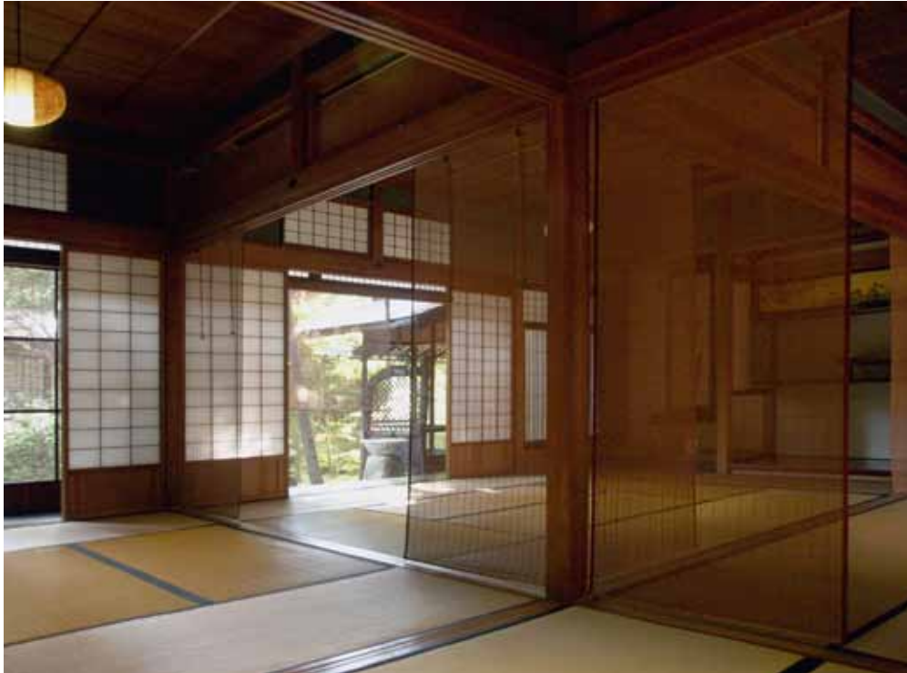
7.1. Las persianas de caña (yoshizu), usadas para dividir el interior de una casa en sustitución de las mamparas correderas; casa patrimonio Yoshijima, Takayama, construida en 1907 según el proyecto de Nishida Isaburo, especializado en casas tradicionales.
