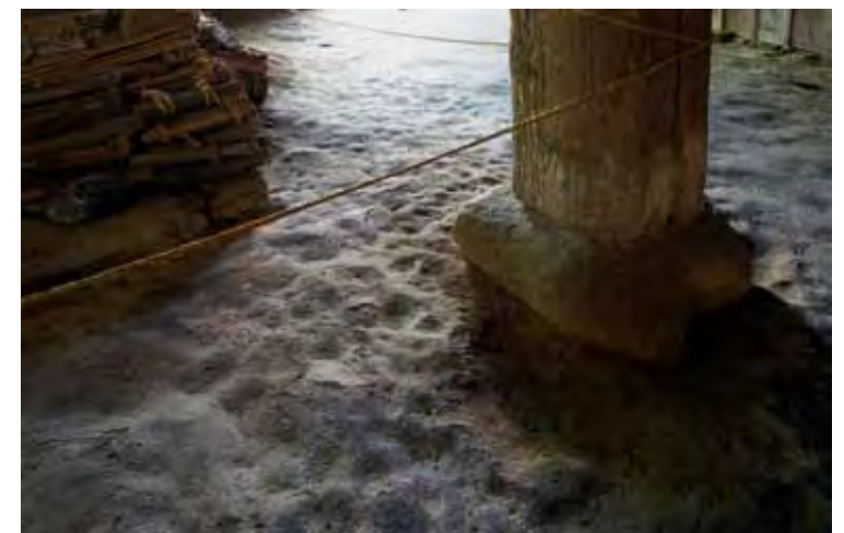
1.2. Apoyo de uno de los pilares sobre el suelo de tierra, casa Egawa.
