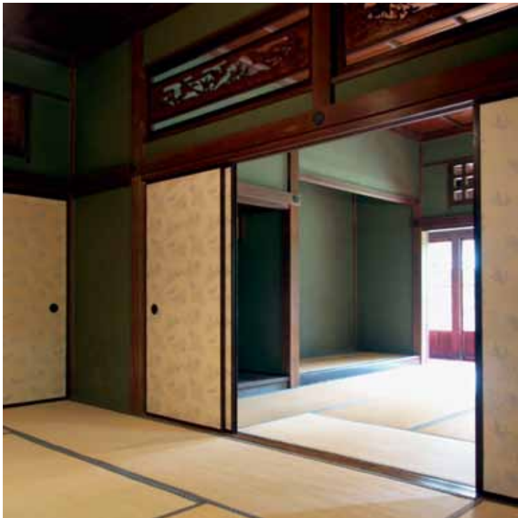
1.1. Ejemplo de nageshi (uchinorinageshi) en la casa de Korekiyo Takahashi, barrio de Akasaka, Tokio, 1902; desmontada y trasladada al Museo de Arquitectura al aire libre Edo-Tokio.
