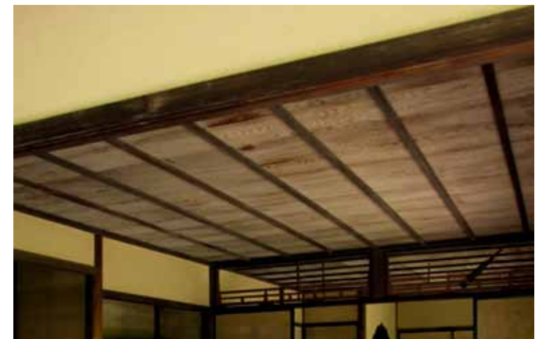
17.2. Techo de tableros y listones (saobuchi tenjō), residencia Rinshunkaku, ‘bien de interés cultural’, principios del periodo Edo (1649); construida originalmente en Iwade, prefectura de Wakayama, era la residencia de verano de Yorinobu Tokugawa, daimyo (‘soberano’) del periodo Edo; ahora en el parque Sankei-en, Yokohama (véase también la figura 17.5).
