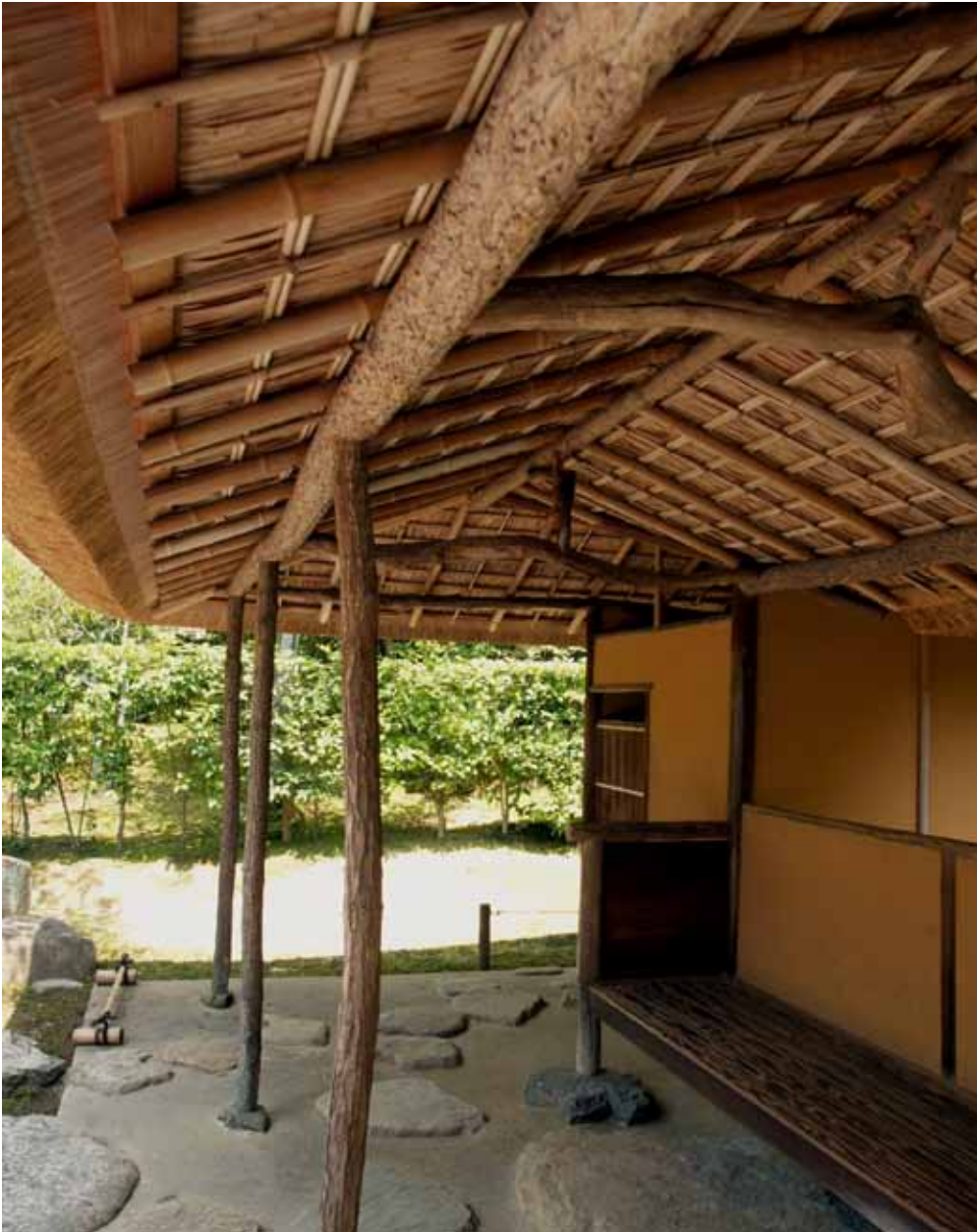
17.1. Techo de vigas al aire que deja a la vista la cara irregular de la cubierta de teja o paja (keshōyane-ura tenjō), villa imperial de Katsura.
